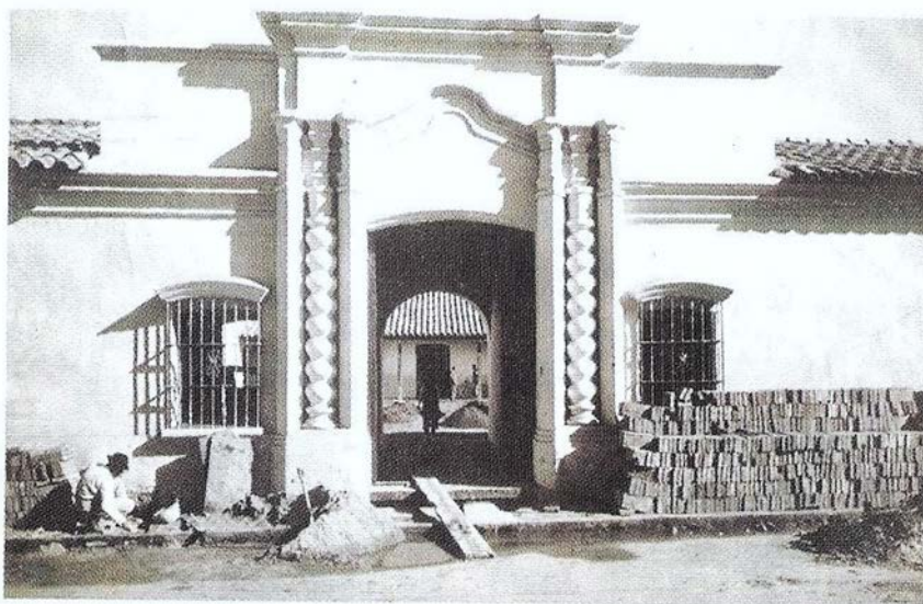
Figura 4. Las obras de reconstrucción. El frente de la Casa Histórica en 1943.
