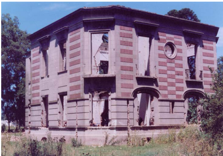
Figura 2. Casona Mansión Seré en estado de abandono. Fotografía tomada durante enero de 1984 y donada al archivo de la DD.HH. el 17 de noviembre de 2008 por Horacio Peralta, exdetenido desaparecido de la ESMA, quien en ese entonces había ido a ver las condiciones en las que estaba la casona junto a un amigo. Fuente: Archivo de la DD.HH. de Morón, Ref. 122.
