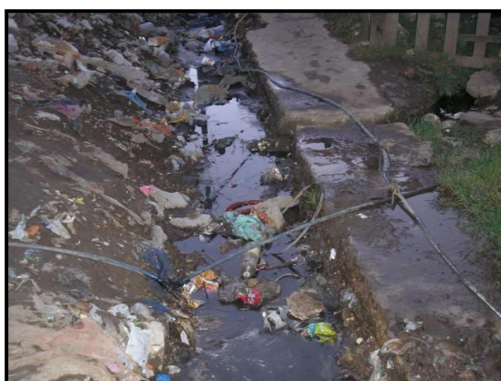
Figuras 5 y 6. Vista de las conexiones a la red de agua potable y descarga cloacal directa a la laguna.
