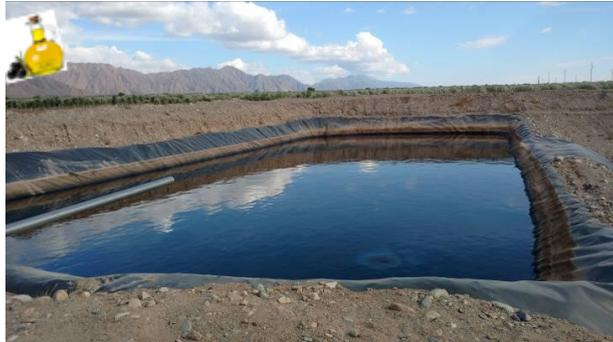
Figura 7.: Disposición de efluentes de aceite de oliva en piletas de evaporación
