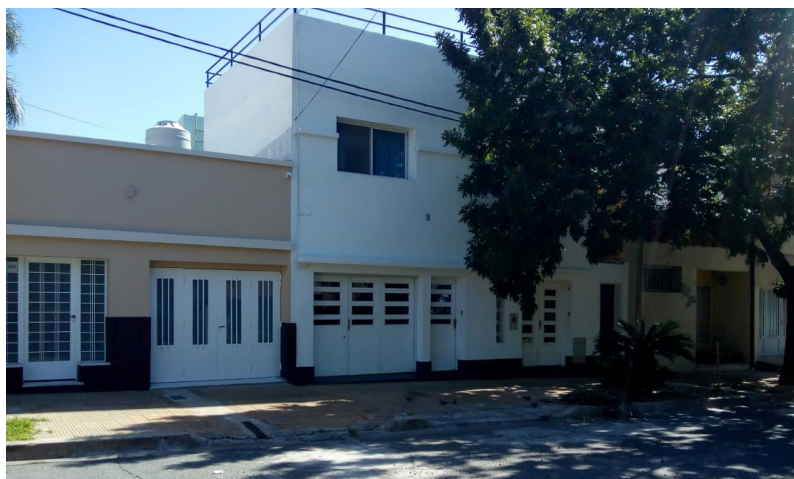
Figura 15. Preponderancia del uso residencial: viviendas unifamiliares y de elevado coste Fuente: registro propio. Año 2021
