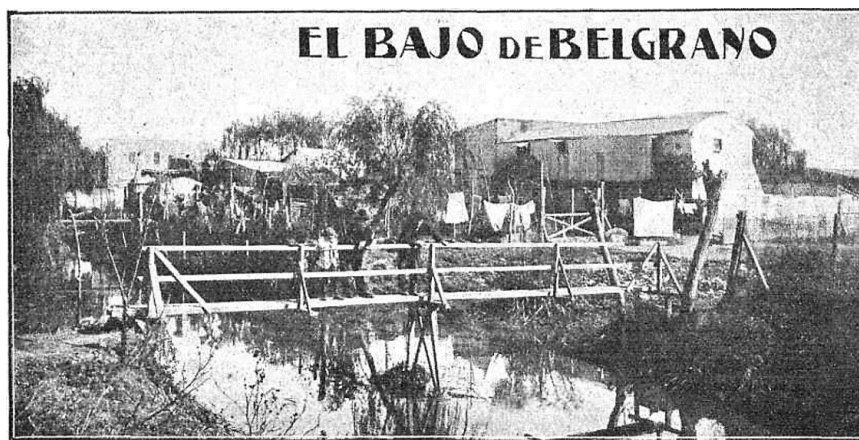
Figura 2. Puente sobre el Arroyo Vega Fuente: Caras y Caretas (1911b)
