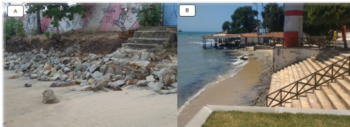
Figura 11. (A) Método de contenção da abrasão marinha. (B) Maré alta chega nas estruturas urbanas
