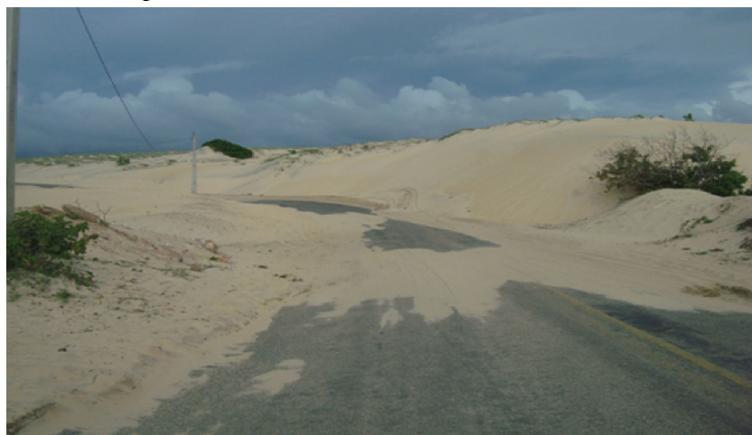
Figura 10. Movimento de duna móvel sobre estrada no local
