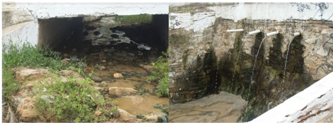
Figura 13. Galerias pluviais que podem prejudicar a saúde da praia bem como seu uso
