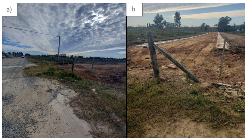
Figura 8. Vista de las obras en dos calles de la ciudad
