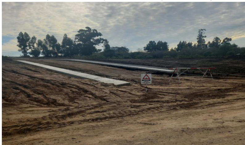
Figura 9. Obra vial que definió una pendiente más pronunciada y un nuevo cauce
