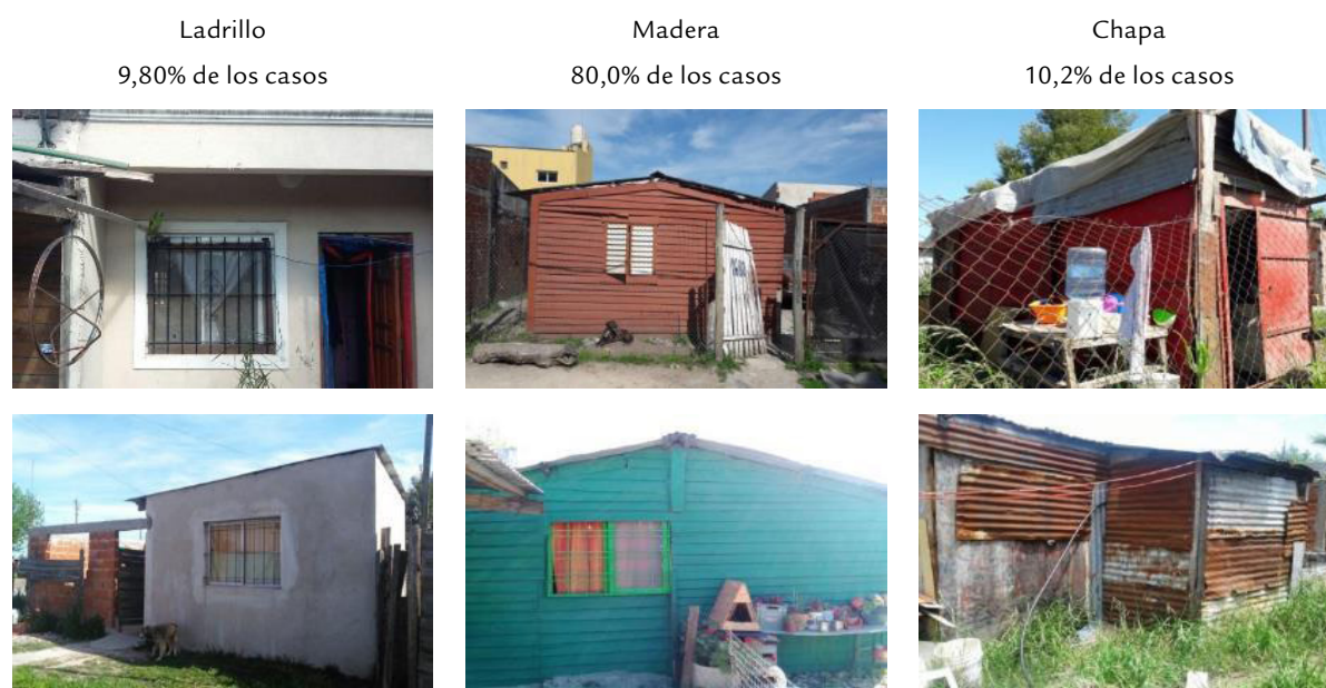
Figura 3. Imágenes de los principales sistemas constructivos relevados y su participación en el total
