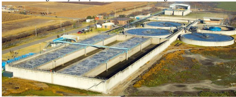
Imagen 9. Ejemplo planta de tratamiento de aguas residuales
